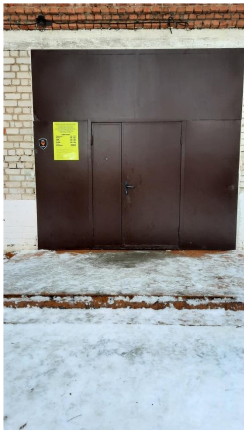
Фото № 4 Входная площадка и дверь
