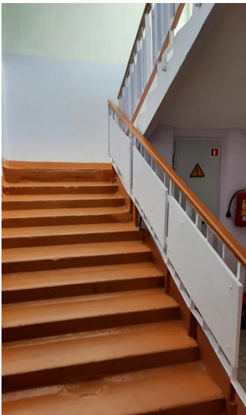
Фото № 8. Лестница внутри здания
