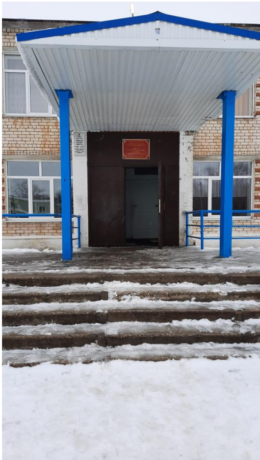
Фото № 4 Входная площадка и дверь
